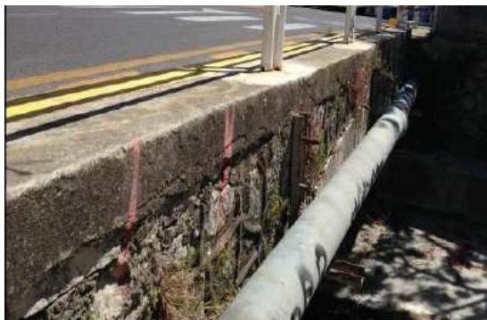
FIGURE 13 : ENTRÉE PASSAGE COUVERT SOUS L'ÉCOLE
